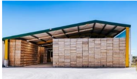
Stockage en bâtiment ouvert
