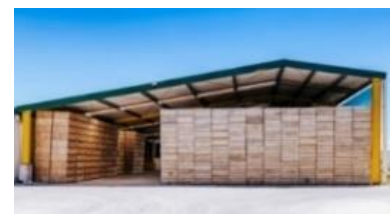
Stockage en bâtiment ouvert
