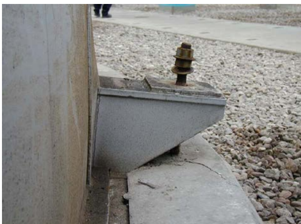
Figure 1.3-10 Allongement de la tige d'ancrage, déformation du réservoir (5000 m 3 gas oil), allongement des tiges filetées et fissuration du béton [65, Magnitude 8.4, Pérou 2001]
