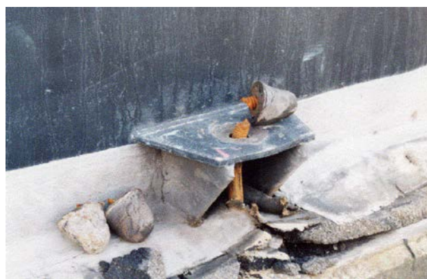
Figure 1.3-9 Endommagement et rupture d'ancrages [54 : Séisme d'Hanshin-Awaji, Japon 1995]
