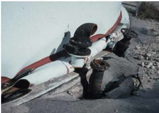
Figure 1.3-8 Rupture de tuyauterie consécutive au flambement de la robe [51]
