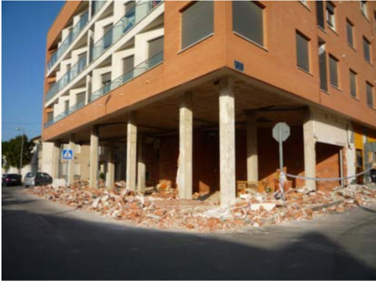
b/ Remplissage en maçonnerie d'un niveau commercial
