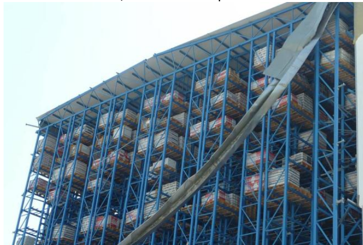
b/ Vue de la structure autoporteuse
