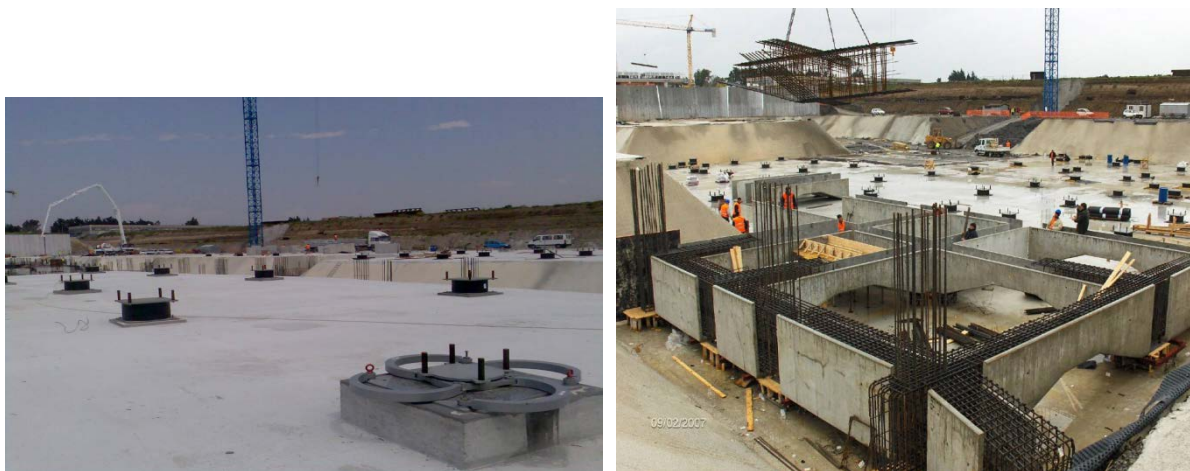
Figure 2-22 : Bâtiment stratégique sur isolateurs et dissipateurs d'énergie (Italie)
