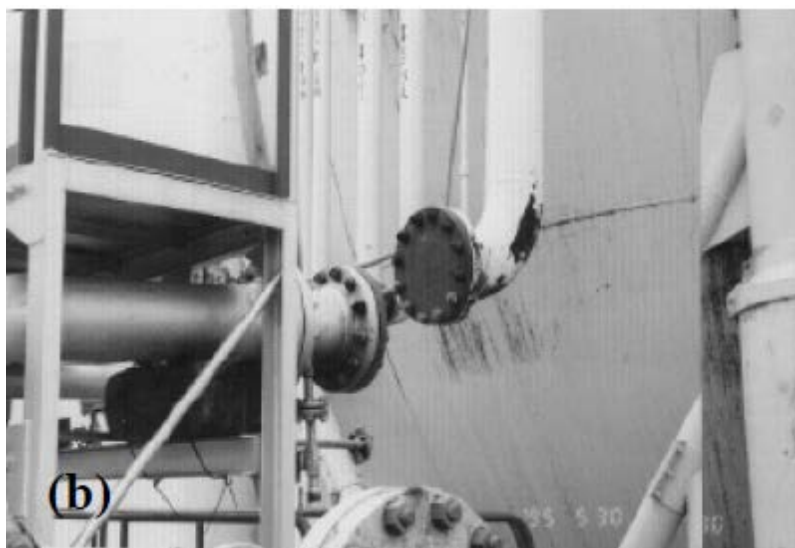
Figure 2-14 : Rupture d'une tuyauterie par déplacement différentiel imposé (d'après [R9])
