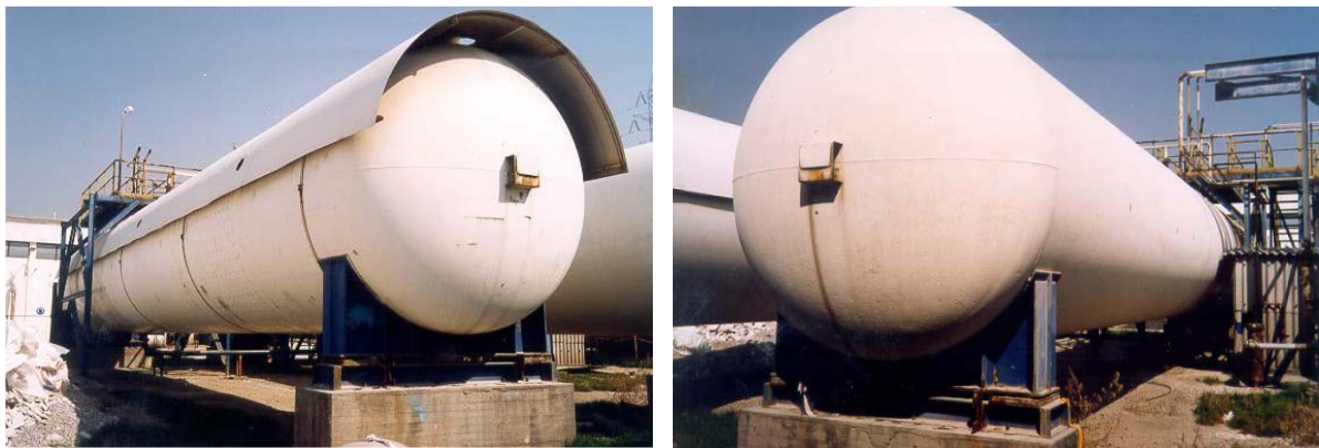
Figure 1-11 : Structures supports en voiles BA de réservoirs cylindriques horizontaux (TRACTEBEL)
