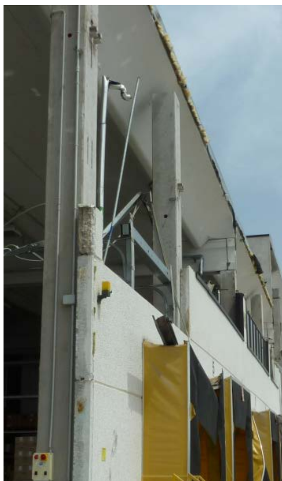
a/ Liaisons d'éléments de façade sous-dimensionnés
