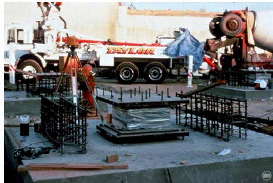
b/ Vue d'un isolateur avant installation
