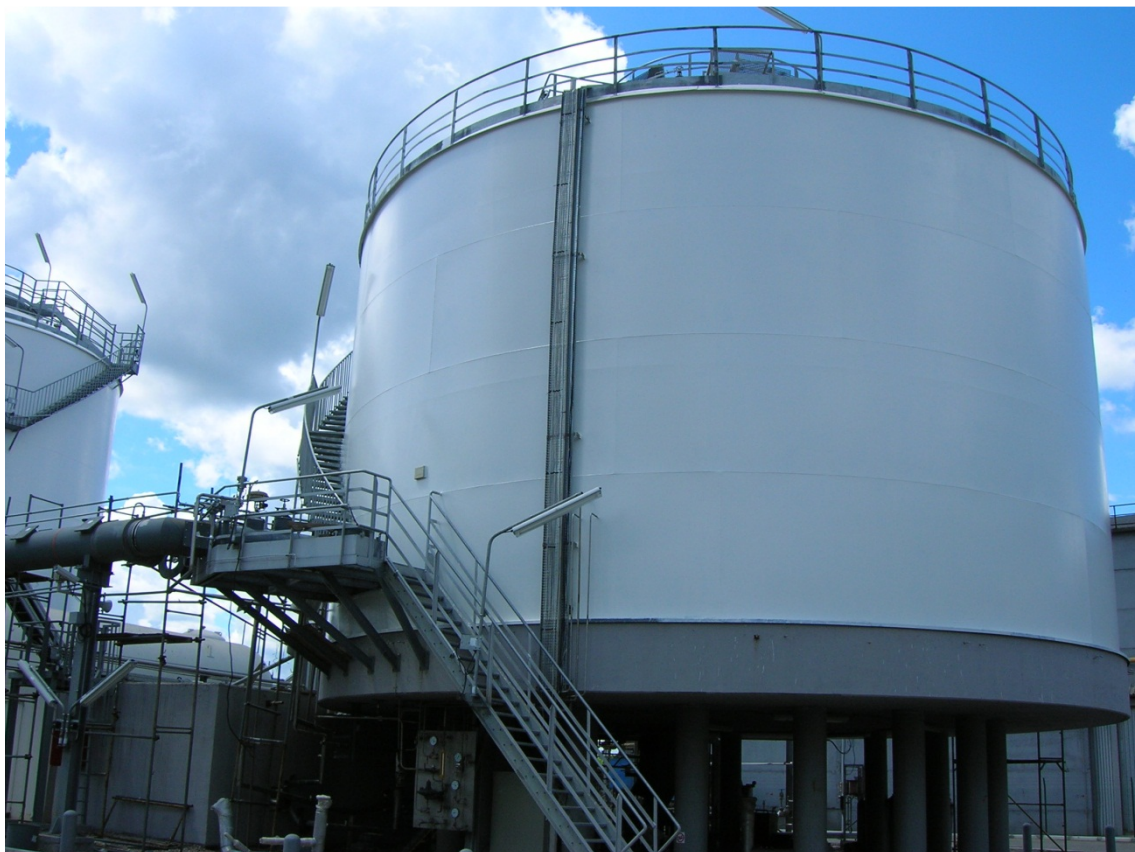
Figure 1-13 : Structures supports de réservoirs
