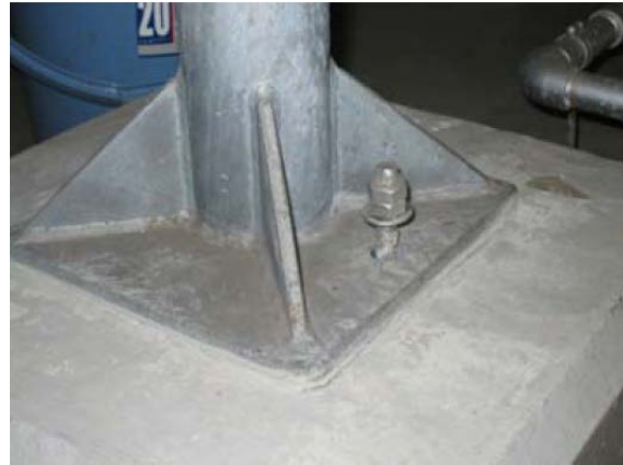
b/ Plastification de la tige d'ancrage
