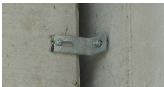
a/ Liaisons d'éléments de façade sous-dimensionnés
