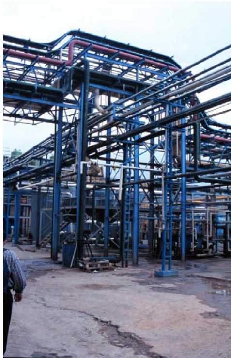
Figure 1-19 : Croisement de racks, mission post-sismique AFPS d'Izmit (1999)
