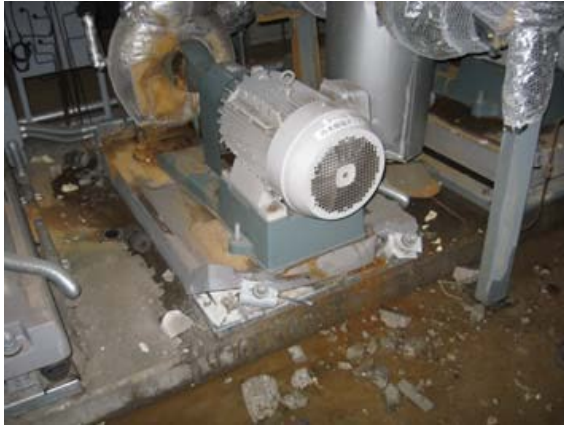
a/ Dommage à la base d'une pompe
