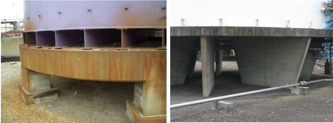
Figure 1-14: Gauche : Réservoirs sur structure porteuse BA (TOTAL), Droite : Réservoirs sur structure porteuse BA (TRACTEBEL)
